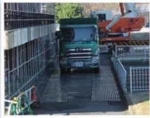
แผ่นปูพื้นเพื่อป้องกันพื้นเสียหายในงานก่อสร้าง
