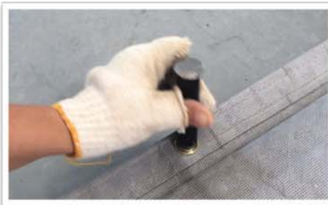
ขั้นตอนการซ่อมแซม
