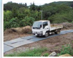
ติดตั้งถนนชั่วคราว/ทางเดินชั่วคราวในพื้นที่ก่อสร้าง
